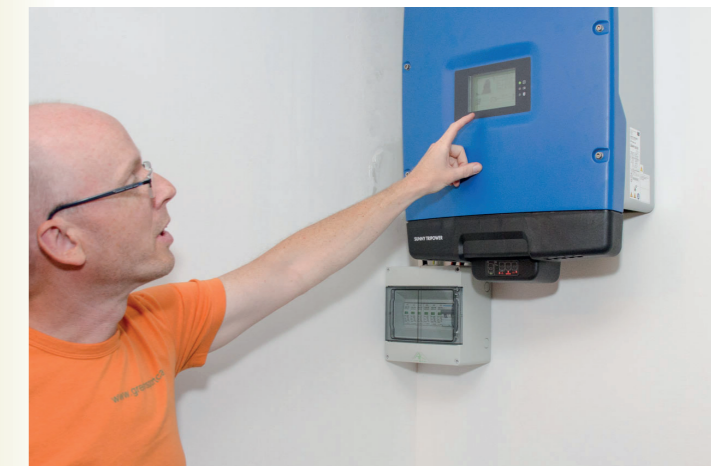
Display informiert immer gut über die Stromproduktion
