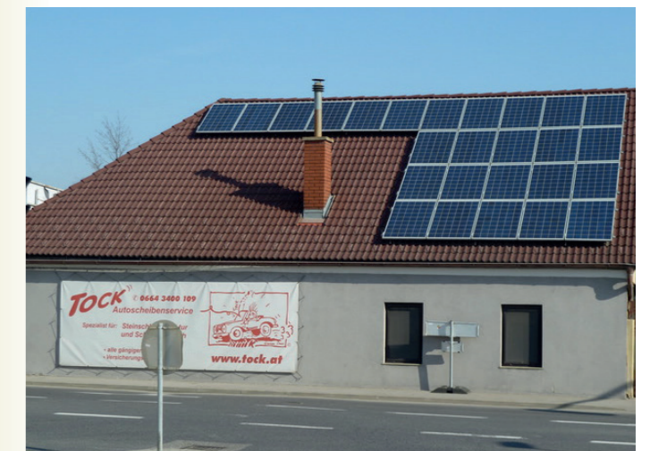
26 Stück KIOTO Module aus Kärnten aufgeteilt in 2 Strings
